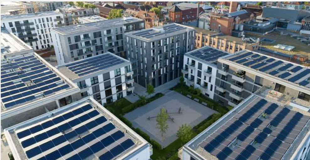
**Bild 2:** Maximale Solarisierung des Gebäudekomplexes „Block B“
