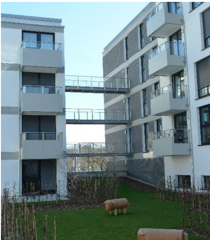
Baufortschritt, © RVI GmbH, Saarbrücken
