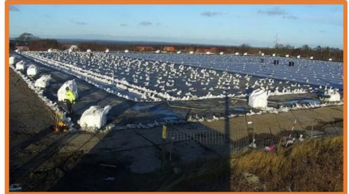
Meldorf: schwimmende Abdeckung, mit Sandsäcken beschwert
