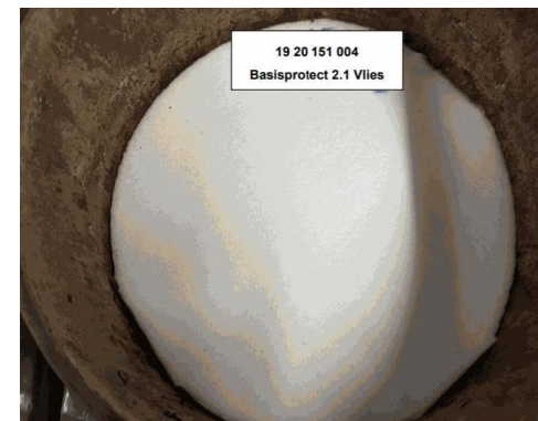
Bild unten: Einbau Schutzlage BasisProtect 2.1
