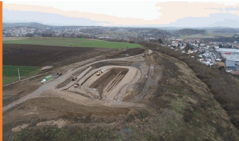
Hechingen: Erdbau im bestehenden Deponiekörper „Hinter Rieb“
