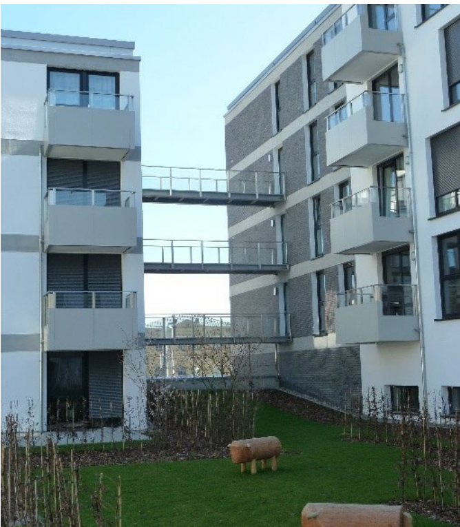
Baufortschritt, © RVI GmbH, Saarbrücken
